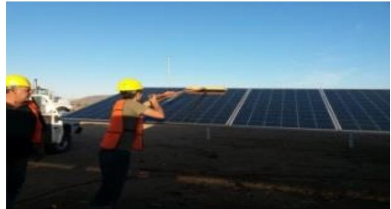
**Figura 5.** Limpieza de los paneles con la técnica de pértigas y agua.
